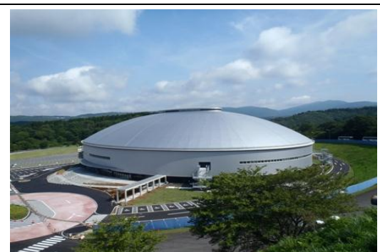
屋内型板張り250mトラック外観
